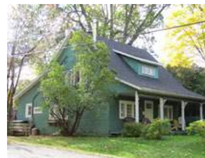
Exemple de bungalow ancien, le 312, rue Labelle, Rosemère.
