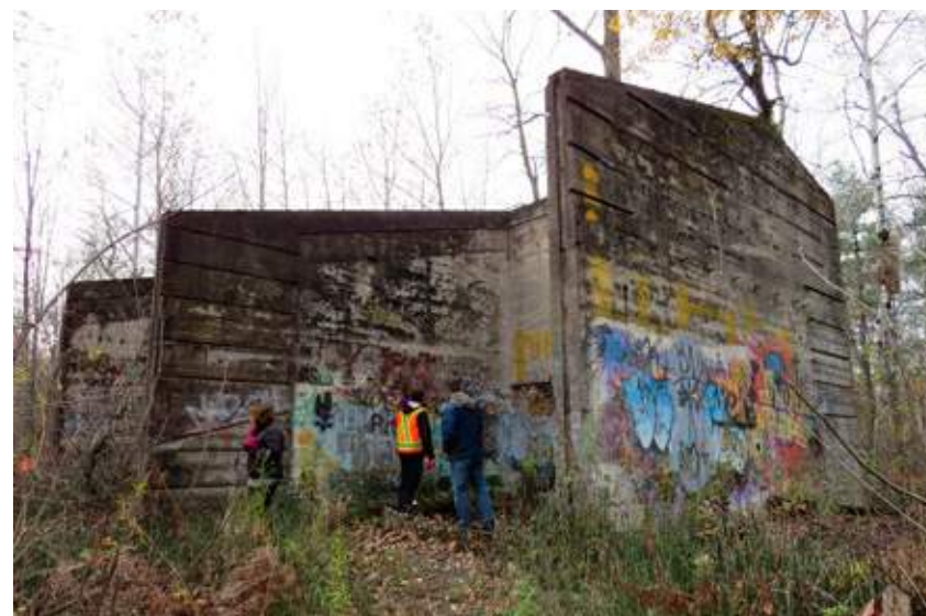
Vestiges en béton de la structure 1. Celle-ci est composée de deux alcôves.
