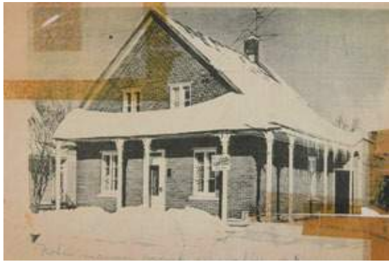
Le 2-6, rue Saint-Stanislas à Sainte-Thérèse avant les travaux de 1961. SHGMI, C001 S2 SS1 D10.
