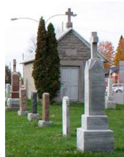
Charnier du cimetière, un bel édifice en pierre à bossage. La couverture de l'édifice est en tôle à baguettes de section triangulaire. 129, boulevard Sainte-Anne, Sainte-Anne-des-Plaines.
