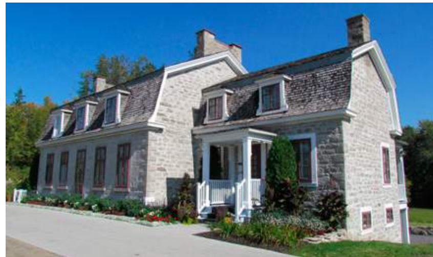
Exemple d'édifice à toit mansardé, la maison Garth au 100, chemin de la Grande-Côte, Lorraine.
