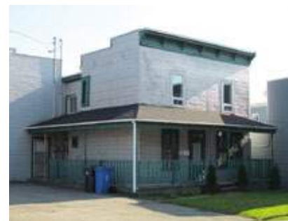
Exemple d'édifice à toit plat, la boulangerie Chartrand au 18, rue Dubois, Sainte-Thérèse.
