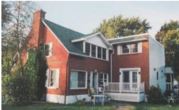
L'édifice a subi d'importantes transformations en 1961, avec l'ajout d'un corps secondaire et la modification de sa fenestration, ce qui a sérieusement altéré son caractère patrimonial.
