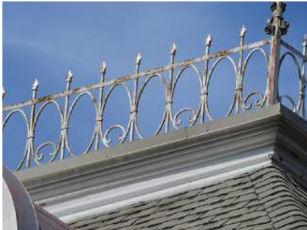
Balustrade de couronnement. Presbytère Sainte-Thérèse d'Avila. 10, rue de l'Église, Sainte-Thérèse.
