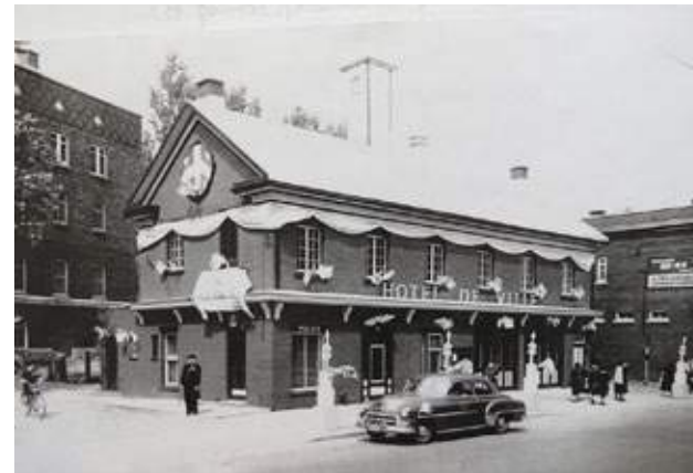
Le Centre J.-Olindo-Gratton tel qu'il apparaît vers 1954. L'abri et le balcon de la façade ont été détruits. L'édifice conserve néanmoins, à ce moment, plusieurs éléments, notamment les fenêtres à battants à petits carreaux du second niveau, la fenêtre circulaire du mur pignon et la tour associée aux services des incendies. 30, rue Blainville Ouest, Sainte-Thérèse. SHGMI. C001 S2 SS1 D5.
