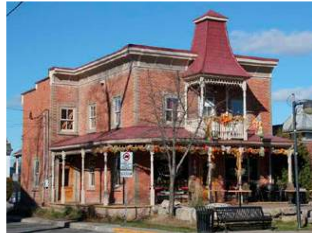
L'un des bâtiments principaux inventoriés à Sainte-Anne-des-Plaines, le 169, boulevard Sainte-Anne, en raison notamment de son intérêt architectural et de sa localisation au sein d'une importante concentration d'architecture ancienne.
