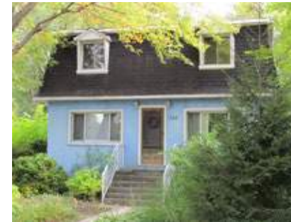
Exemple de maison à fausse mansarde, le 220, chemin de la Grande-Côte, Rosemère.
