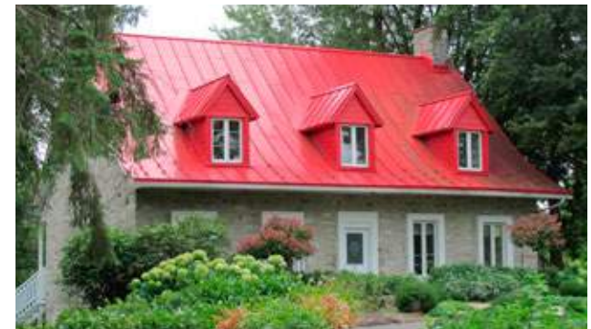
Maison Hamilton, datant de 1796. 106, chemin de la Grande-Côte, Rosemère.
