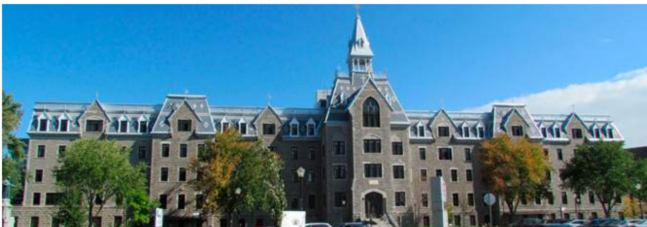
La façade de l'ancien séminaire, photographiée en 2014. L'on constate surtout le remplacement des fenêtres et la disparition de la plupart des crêtes faitières en bordure du toit. À l'arrière toutefois, des changements plus importants ont été effectués : agrandissement du côté nord en 1951, puis démolition de la chapelle qui avait été érigée en 1898.
