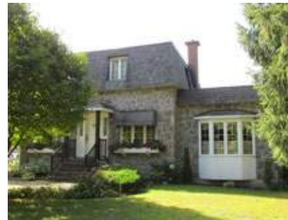
Exemple de maison à fausse mansarde, le 255, montée Sanche, Boisbriand.
