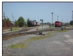
Voie ferrée du CP (photo GGBB)
