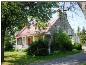
331, chemin de la Grande-Côte (photo GGBB)
