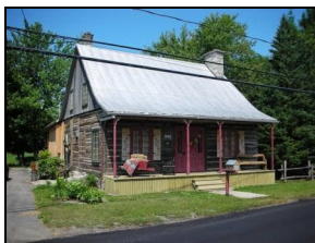
541, chemin de la Grande-Côte (photo GGBB)
