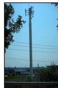
Tour de télécommunication (photo GGBB)
