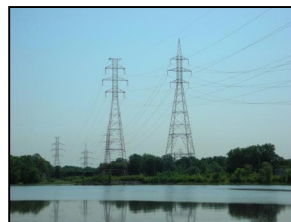
Ligne hydro-électrique (photo GGBB)
