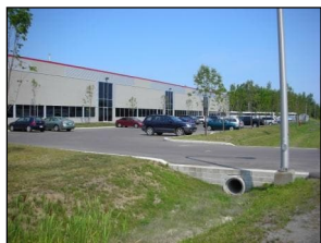
rue Marcel-Lacasse (photo GGBB)
