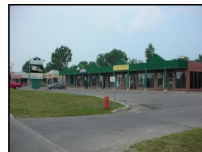
chemin de la Rivière-Cachée (photo GGBB)
