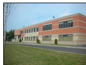
École des Grands-Chemins (photo GGBB)
