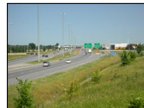
Autoroute des Laurentides (A-15) (photo GGBB)
